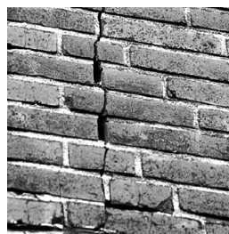
Ремонт и реставрация кирпичной кладки.
