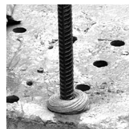
Устройство арматурных выпусков
