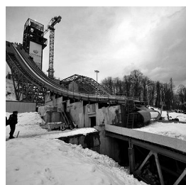
Применение в экстремальных условиях горных строительных объектов.
